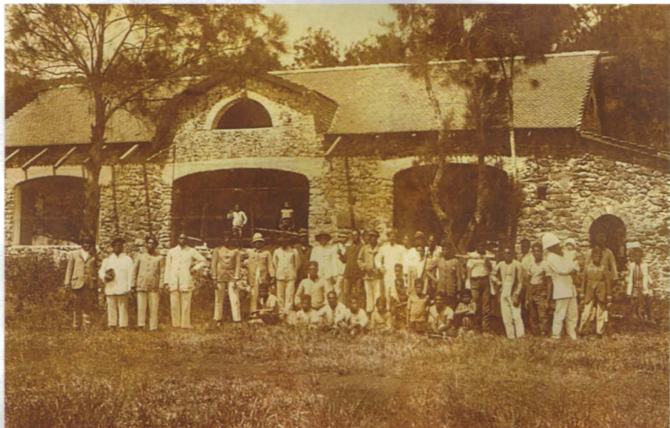
La vieille école en construction : il manque encore les fenêtres et les vitraux (1921).
